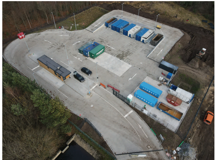
Die Luftaufnahme der Baustelle im Oktober 2020 zeigt das Leitsystem auf dem neuen Recyclinghof: Über die Waage am Eingangsbereich führt der Weg vorbei an den Stellplätzen der verschiedenen Container. Alles als Einbahnstraße. (Foto: © GEG)
