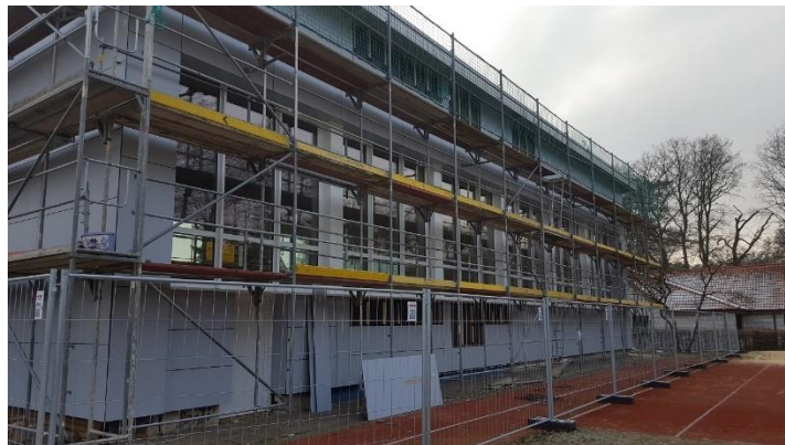
Bild: neue Wärmedämmung an der Turnhalle der Michaelschule
