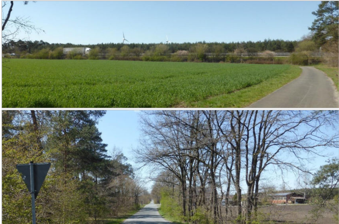
Abb. 13 Westlich angrenzende A 33 in anteiliger „Hochlage“ und begleitenden Böschungen (oben), Blick von Osten über den von Gehölzen gesäumten Lippstädter Weg (unten)
