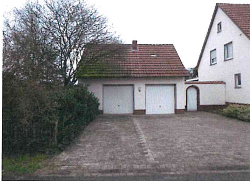
Abb. 14 Garage im Bereich der geplanten Erschließungsstraße.
