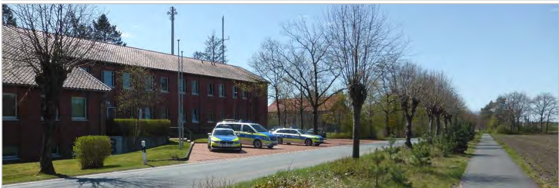
Abb. 15 Campingplatz „Am Furlbach“ nordöstlich der Planflächen (oben), Gebäude der Autobahnpolizei im Nahbereich der Polizeischule südöstlich des Lippstädter Wegs (unten)
