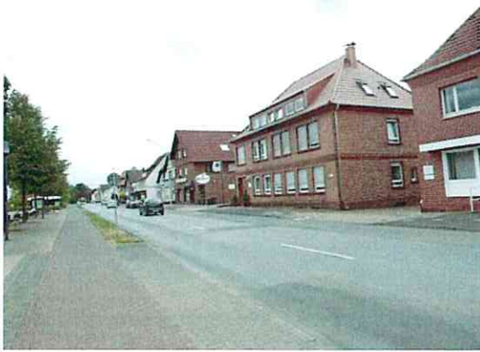
Abb. 4 Blick auf die Bahnhofstraße und die Bebauung an der Bahnhofstraße im Nordosten des Plangebietes.
